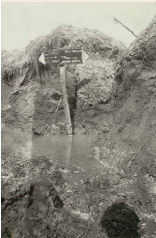
■ Pancartes de signalisation dans une tranchée Raphaël Binet, photographie
